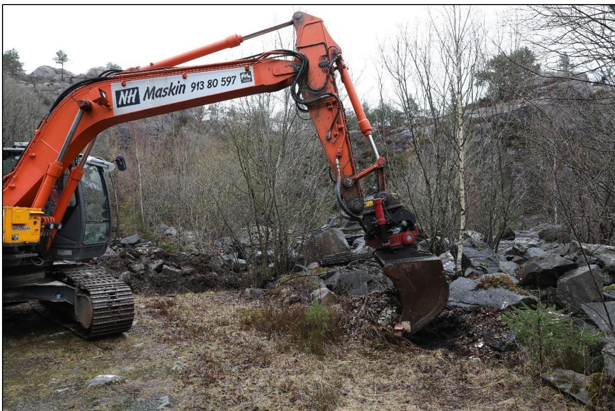
**Fig. 6.** Prøvesjakten ble gravd med gravmaskin. Alle prøvegropene ble fylt med masser og ordnet etter gjennomført prøvetaking. 29. mars 2021. Foto: A. Håland.
